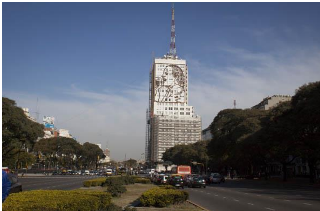
Fig. 2 : « Eva », façade nord de l'ancien Ministerio de Obras Públicas.
